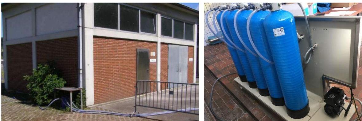
Abbildung 64: Anlagenstandort „alte Endkontrolle“ (links) mit 48 L Adsorbern (rechts) für die Versuche mit kommunalem Abwasser
