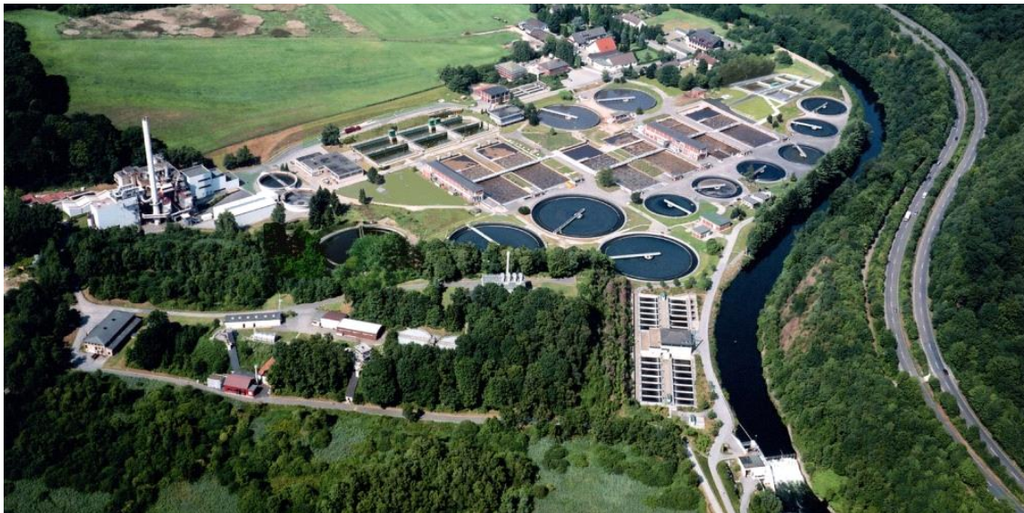
Abbildung 62: Kläranlage Buchenhofen mit Flockungsfiltration im Vordergrund
